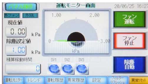
タッチパネル式運転モニター
